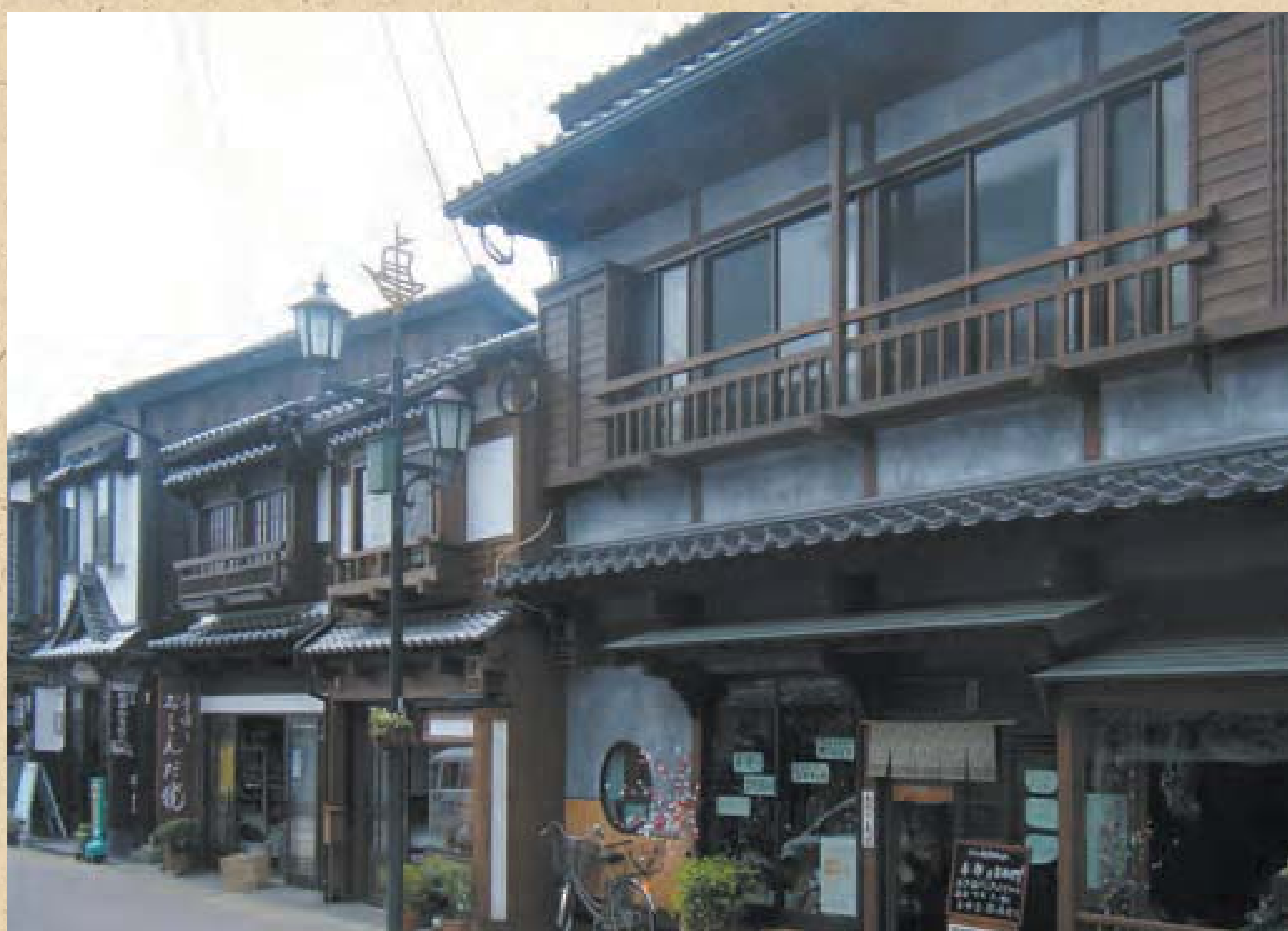
平戸城下旧町地区（オランダ商館通り）
