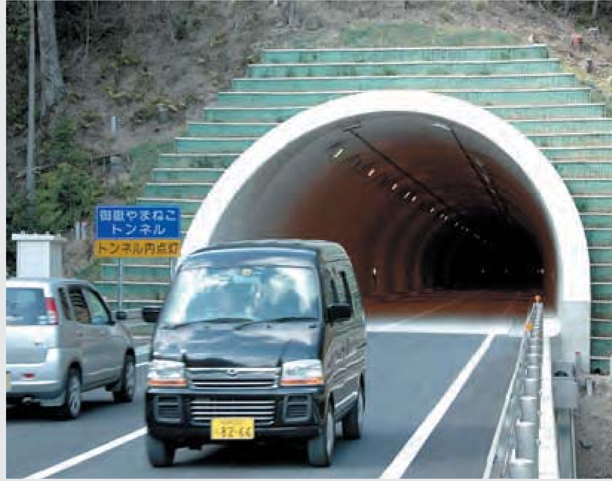
どう坂バイパス(対馬市) 平成21年3月供用
