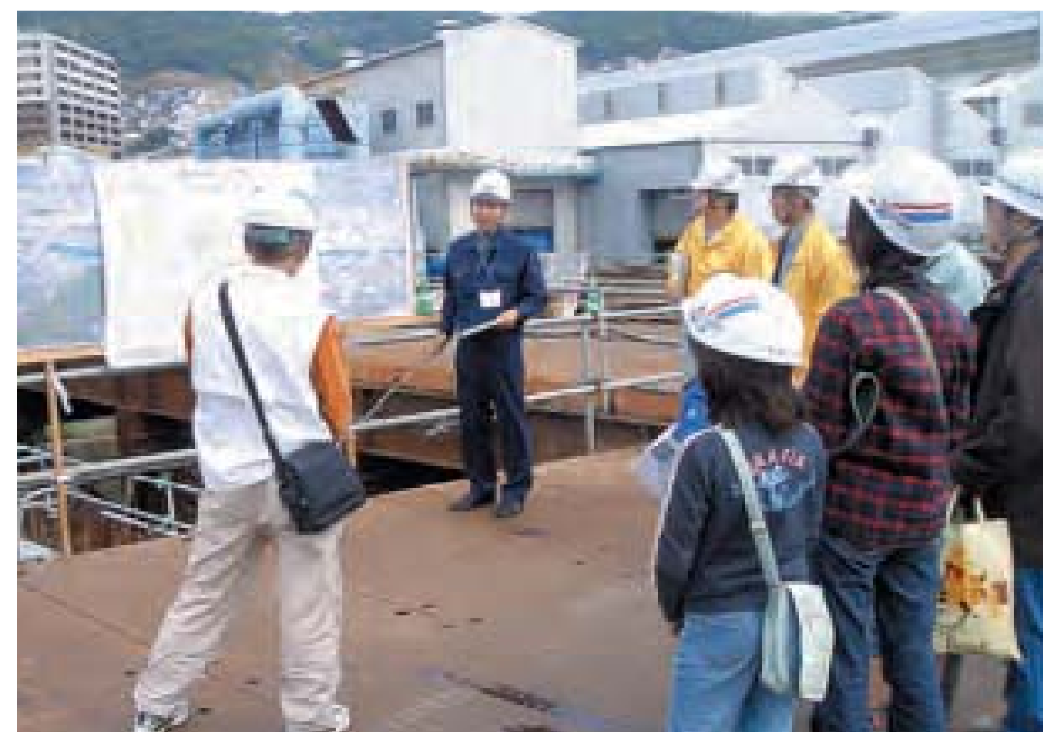
浦上川仮設棧橋
