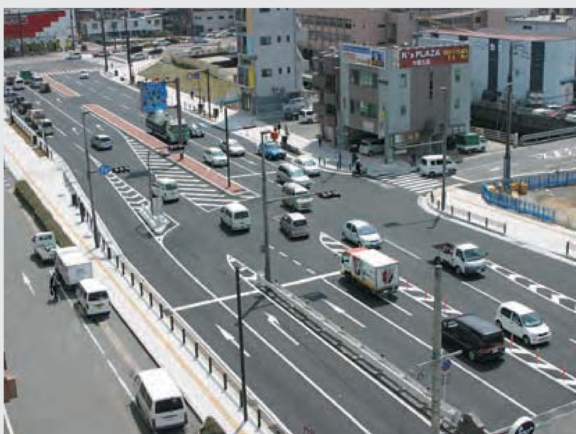
都市計画道路 旭大橋線(長崎市尾上町) 平成20年3月供用
