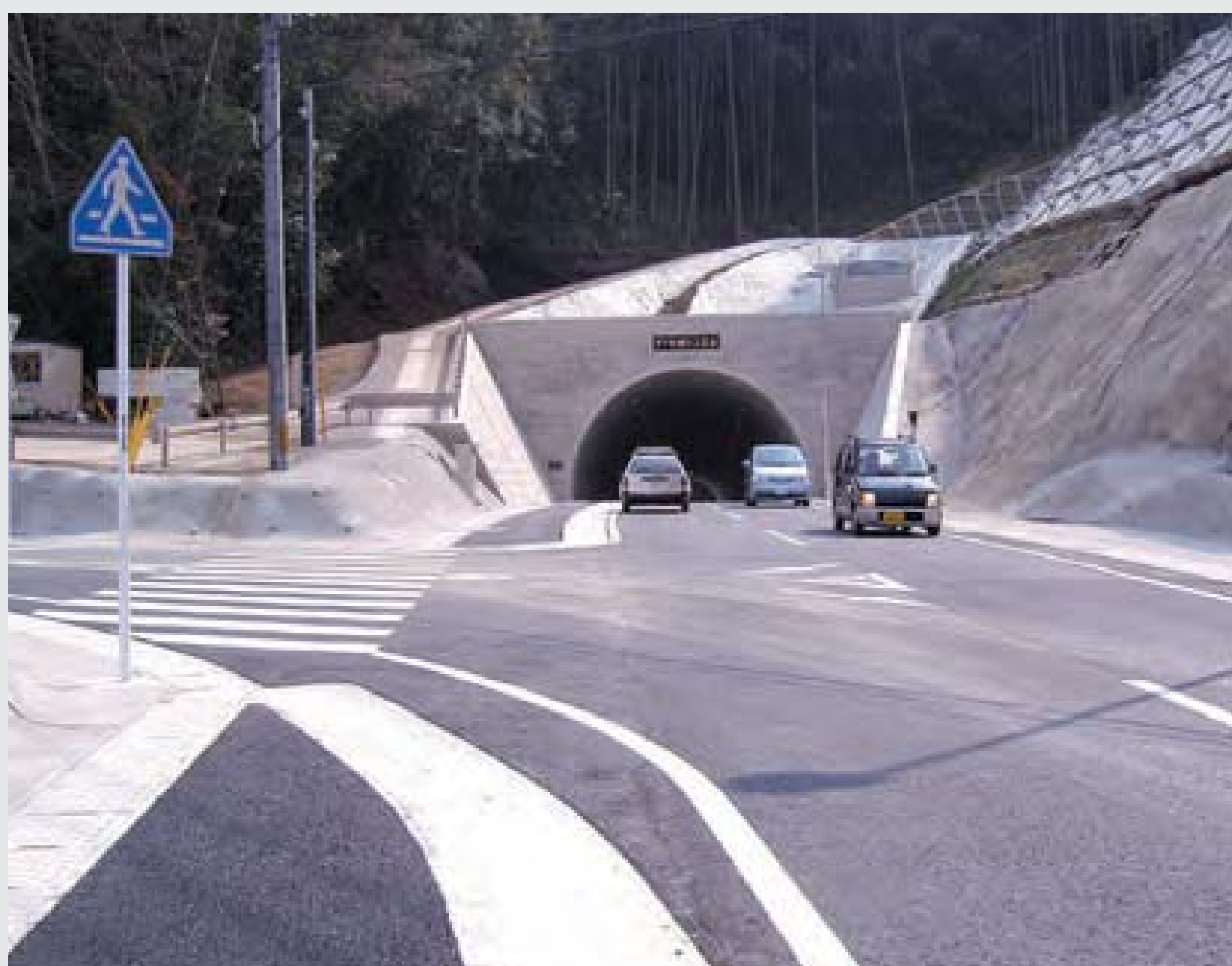
国道382号(対馬市濃部) 平成19年12月供用
