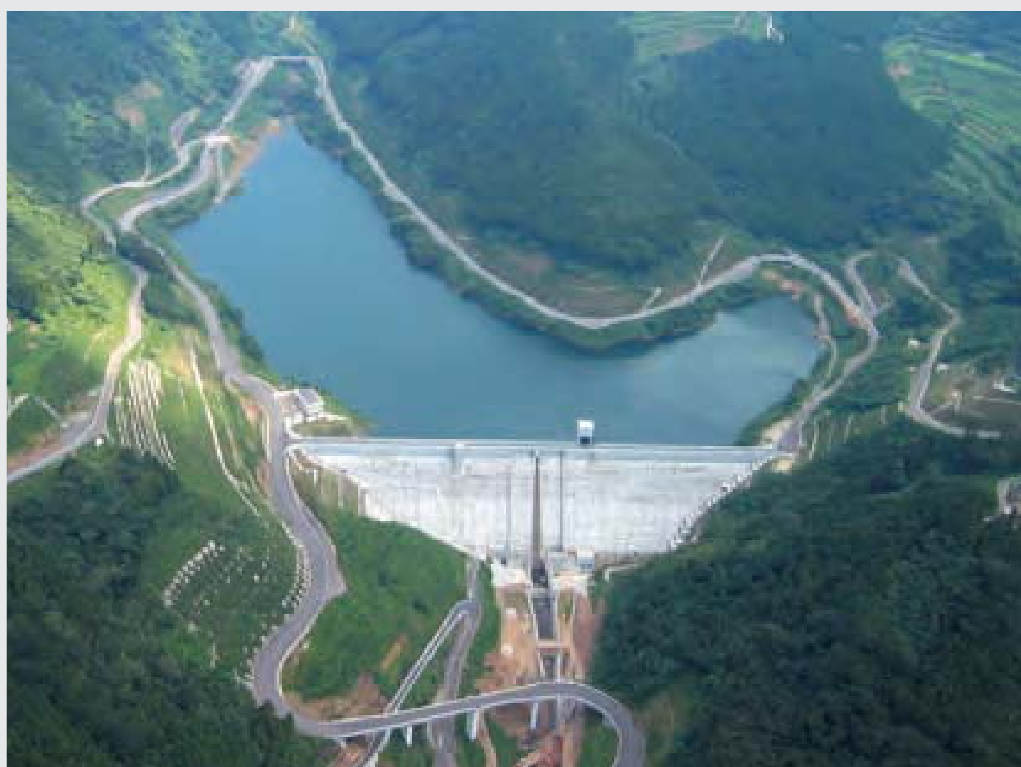
笛吹ダム(松浦市) 平成19年11月竣工
