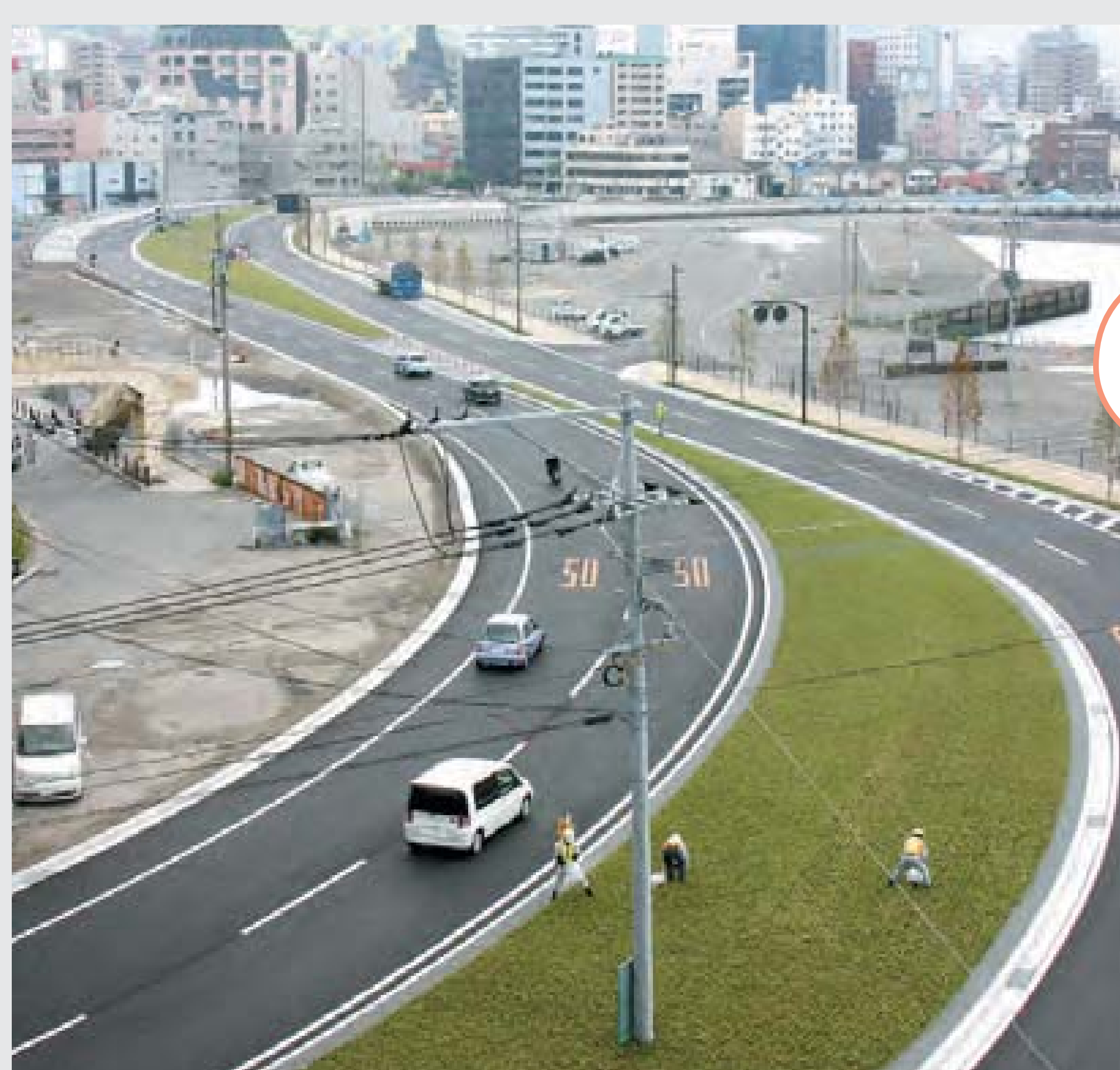
都市計画道路 浦上川線(長崎市元船町～幸町) 平成20年3月一部供用
