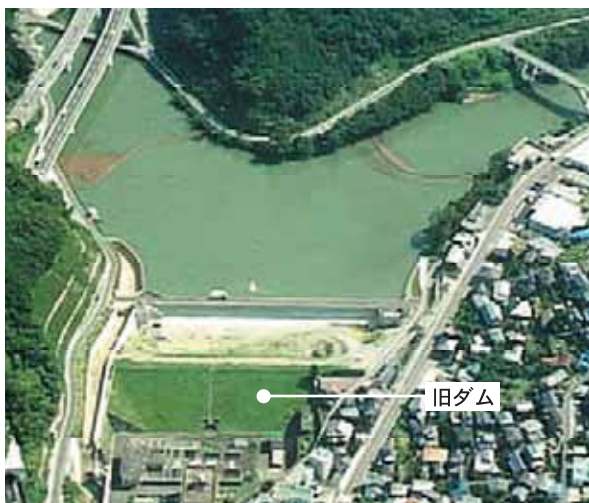
平成18年度、新しい高部ダムは完成しました。現在、本河内低部ダムの工事を行っています。
