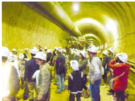
現場見学会(千綿トンネル)
