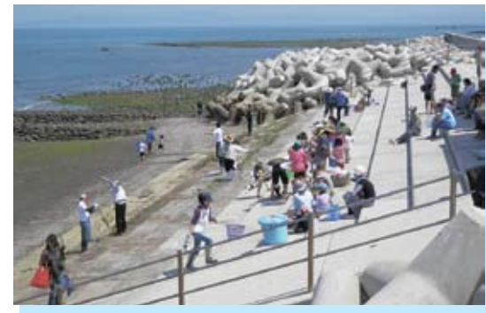
島原港海岸保全事業 島原市
