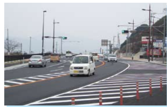
国道34号大村拡幅 大村市
