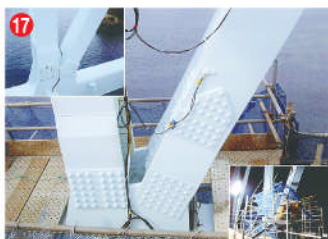
工事名 主要地方道平戸生月線道路災害防除工事(生月大橋本復旧) 施工者 大島・三菱JV 技術者 元川 貴文 工事内容 橋を使いながら修理する工事です。
