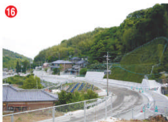
工事名 主要地方道野母崎線道路改良工事(3工区) 施工者 ㈱中嶋組 技術者 高谷 力 工事内容 道路を新設する工事です。
