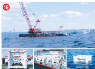
工事名 長崎南地区広域漁港整備工事(崎戸島南2工区) 施工者 黒瀬建設㈱ 技術者 河野 正一 工事内容 魚礁を造り、海中に設置する工事です。
