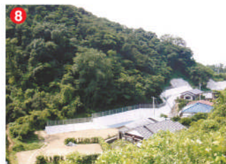
工事名 宮ノ前(1)地区急傾斜地崩壊対策工事 施工者 ㈱法面 技術者 藤田 浩之 工事内容 げけの崩壊を防止する工事です。
