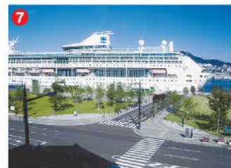
工事名 長崎港松が枝国際観光船舶頭整備工事(道路A) 施工者 ㈱西海建設 技術者 小川 一貴 工事内容 松が枝国際観光船舶頭のアクセス道路を造る工事です。
