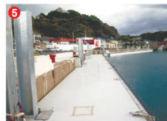
工事名 芦辺地区広域漁港整備工事(1工区) 施工者 ㈱岡本組 技術者 濱口 史広 工事内容 浮桟橋を設置する工事です。
