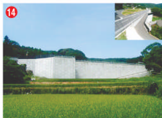
工事名 一般国道383号道路改良工事(1工区) 施工者 平戸建設㈱ 技術者 川本 豊二 工事内容 道路を補強・拡幅する工事です。
