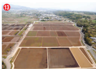
工事名 牟田地区区画整理工事(1-2工区) 施工者 本間建設㈱ 技術者 古里 初則 工事内容 水田の区画を整える工事です。
