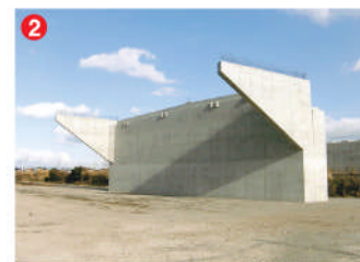
工事名 一般国道251号橋梁整備工事(宮添高架橋A2) 施工者 ㈱有馬 技術者 本多 豊次 工事内容 橋の橋台を新設する工事です。
