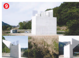
工事名 主要地方道佐世保吉井松浦線橋梁整備工事(大渡高架橋A2) 施工者 ㈱協和土建 技術者 石原 洋 工事内容 橋の橋台を新設する工事です。
