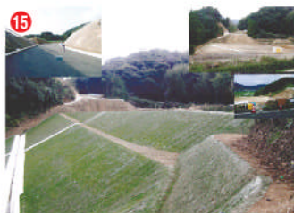
工事名 主要地方道佐世保吉井松浦線道路改良工事 施工者 松浦建設㈱ 技術者 村山 司之 工事内容 道路を補強・拡幅する工事です。
