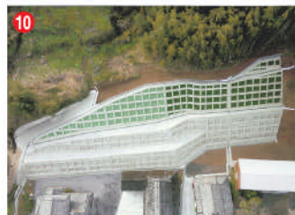
工事名 石崎(2)地区急傾斜地崩壊対策工事 施工者 ㈱豊恒 技術者 川野 雄輔 工事内容 げけの崩壊を防止する工事です。
