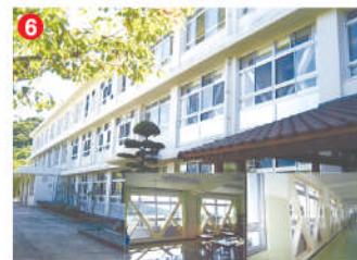
工事名 奈留高校管理教室棟耐震改修(2期)工事 施工者 ㈱才津組 技術者 村里 重則 工事内容 高校校舎の耐震化工事です。
