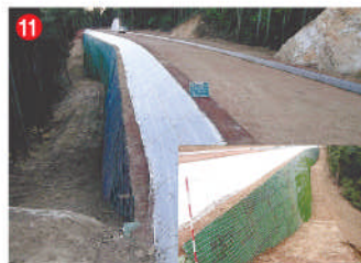
工事名 寺西2期地区農道工事 施工者 下條建設㈱ 技術者 橋口 武士 工事内容 農道の補強をする工事です。
