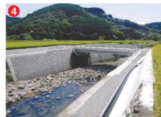
工事名 川棚川河川改修工事(上石木橋) 施工者 ㈱西部工建 技術者 山田 賢次 工事内容 河川の拡幅に伴う橋の架替え工事です。
