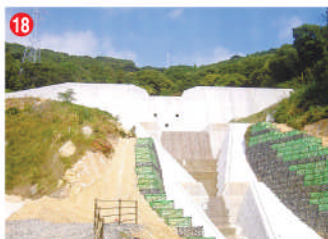
工事名 小奈良尾脇川通常砂防工事 施工者 大宝建設㈱ 技術者 戸村 敬一 工事内容 土石流から家を守る工事です。
