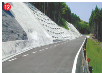
工事名 西彼杵半島線森林基幹道開設工事(小松工区) 施工者 ㈱進成 技術者 川谷 裕輔 工事内容 林道を新設する工事です。
