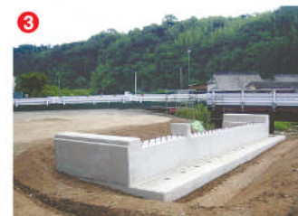
工事名 主要地方道小浜北有馬線交通安全施設等整備工事(西正寺橋A2) 施工者 宅島建設㈱ 技術者 高橋 勇樹 工事内容 橋の橋台を新設する工事です。
