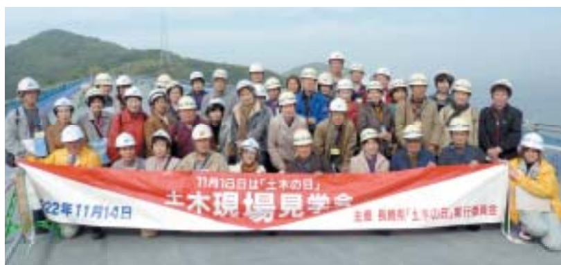
伊王島大橋橋梁整備工事
