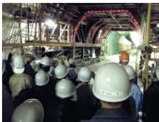
九州新幹線鈴田トンネル
