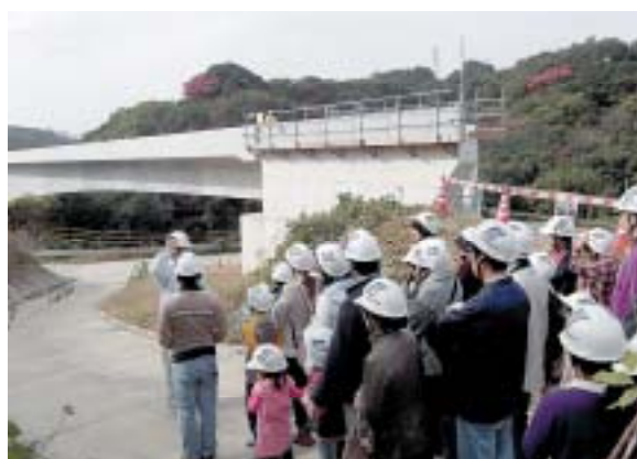
一般国道202号橋梁整備工事(江上橋上部工)
