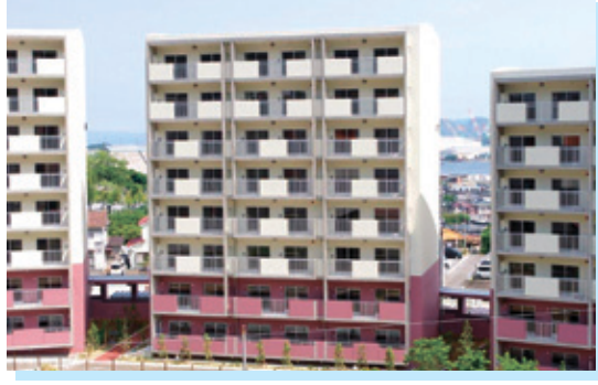
県営住宅(深堀団地C-1、2、3棟) 長崎市 建替工事によって、県営住宅の居住機能及び耐震性の向上が図られました
