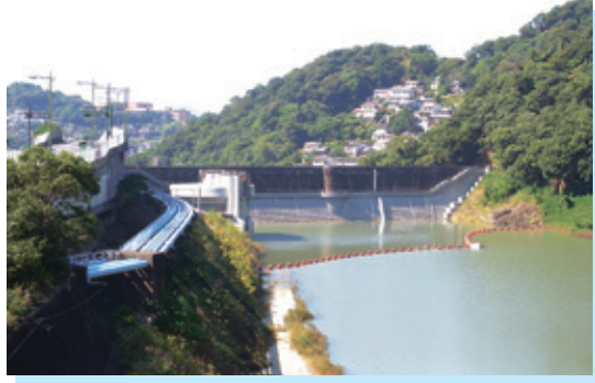
本河内低部ダム(長崎水害緊急ダム事業) 長崎市 明治36年完成の水道専用ダムの再開発工事により、洪水調節機能を備えた多目的ダムに生まれ変わりました
