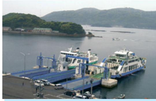
瀬戸港定期船ふ頭整備 西海市 瀬戸港と松島・池島及び佐世保港を結ぶ、フェリー及び高速旅客船用ふ頭を整備し、利用者の利便性向上と安定した輸送手段を確保します
