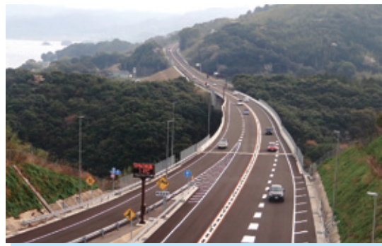
小迎バイパス(国道206号) 西海市 地域高規格道路「西彼杵道路」の一部であり、時間短縮効果による地域間の交流促進や連携強化等が図られ、地域の活性化が期待されます
