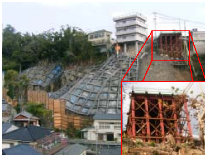
【写真－5 仮設構台設置状況】
