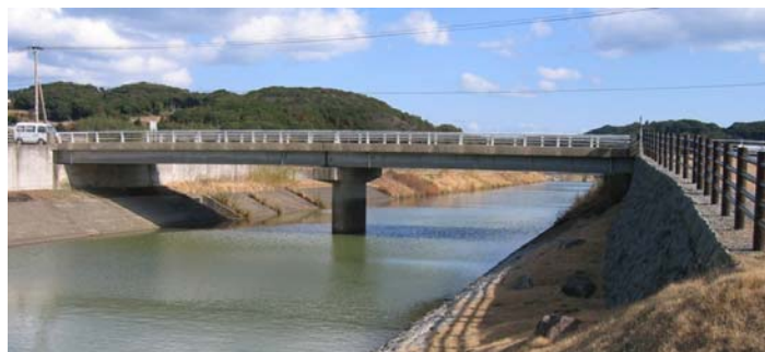
写真 2-1.津合橋現況写真
