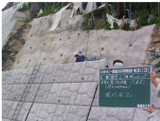
【写真－7 大型ブロック施工状況】
