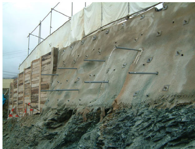
【写真－8 横穴ボーリングによる湧水処理状況】
