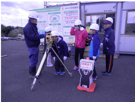
③まずは工事の基本である測量業務を体験
