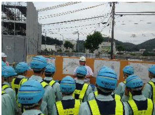
橋脚現場事前説明
