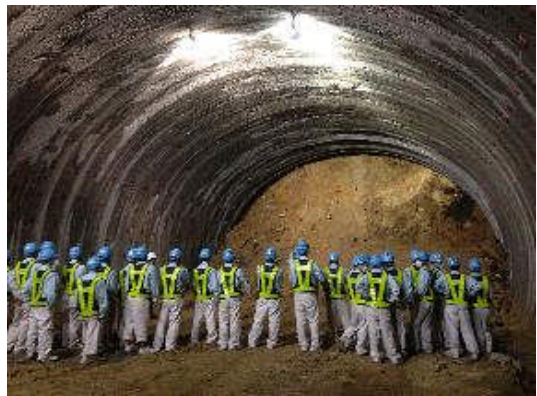
トンネル坑内見学状況③
