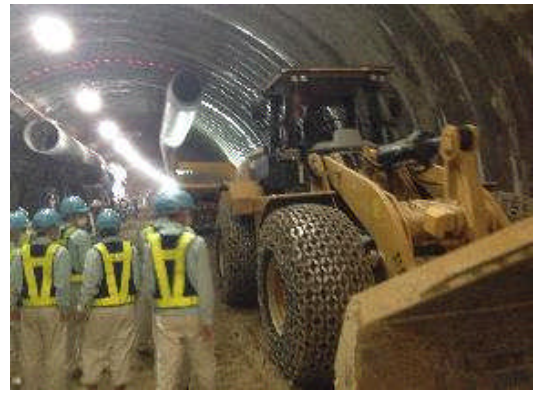
トンネル坑内見学状況①
