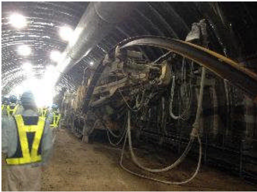
トンネル坑内見学状況②
