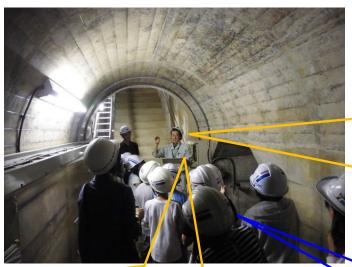
ダム堤体の中には、ダム堤体に水漏れが発生していないかや、ダムに作用している力(はあったが、でありが異常でないがなどを計測する機械があります。
