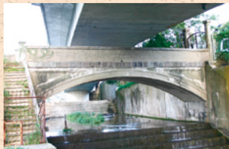
■本河内低部ダム放水路橋(明治36年(1903)3月)
