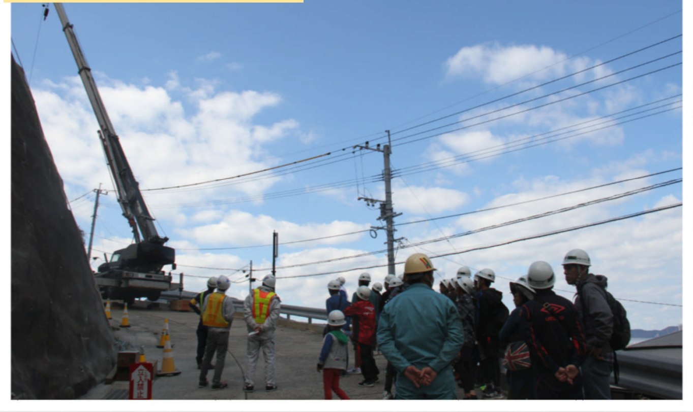
クレーン車作業見学
