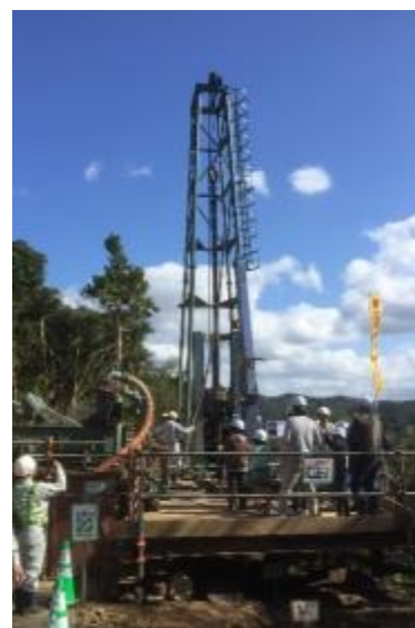
大口径ボーリングマシンの運転状況
