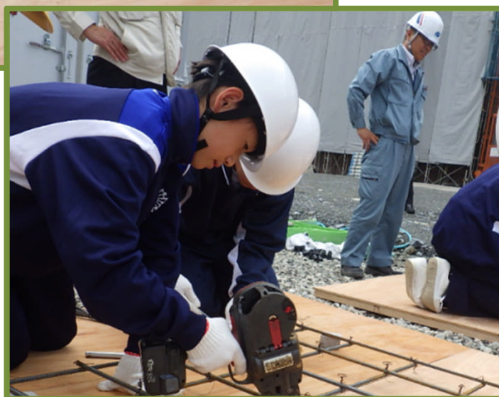
④鉄筋結束体験
