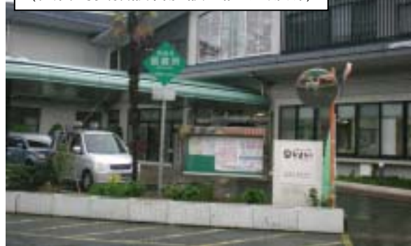
写真 デイサービスセンター (災害時要援護者施設 兼 避難所)
