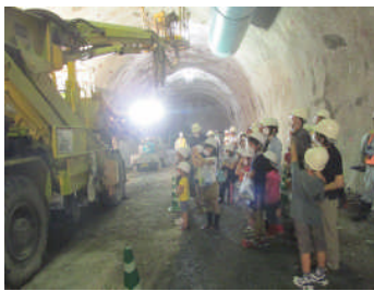
▲トンネル掘削用機械の説明
