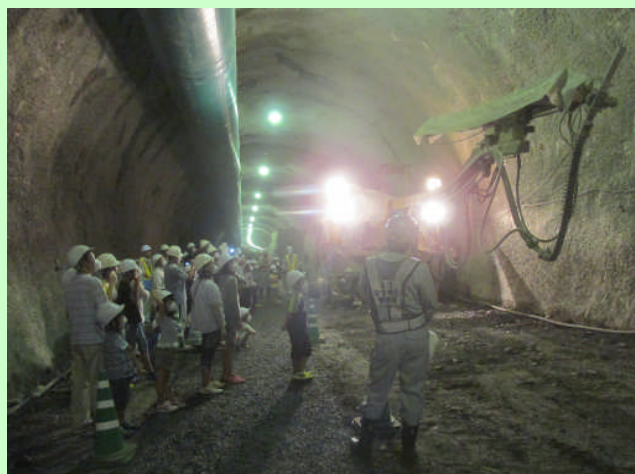
▲ドリルジャンボや吹付機を動かし、掘削や吹付作業の施工状況を説明
