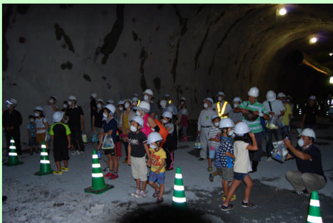
▲初めて見る工事中のトンネル内の様子をカメラに収めていた。
