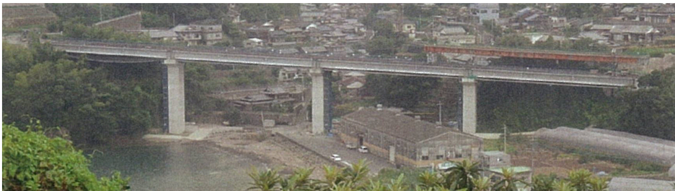
▲建設状況写真 【主要地方道野母崎宿線道路改良工事 片峰橋（長崎市飯香浦）】
