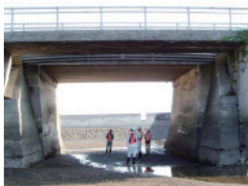
橋梁の定期点検状況
