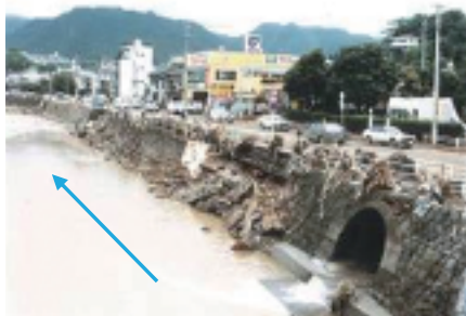
長崎大水害（S57.7.23）の被災状況
