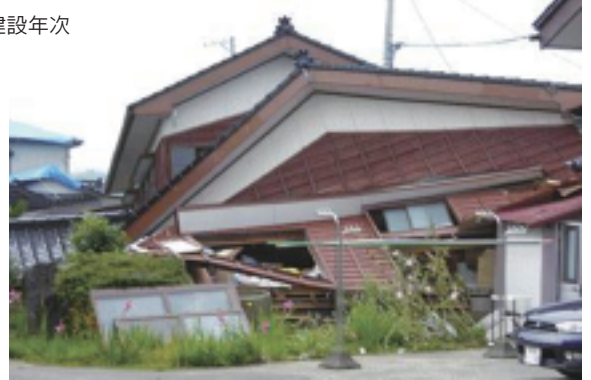
地震により倒壊した住宅
