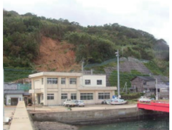
人家裏の斜面が崩壊（平成18年 五島市）
