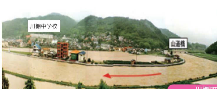
平成2年水害（H2.7.2）の被災状況
