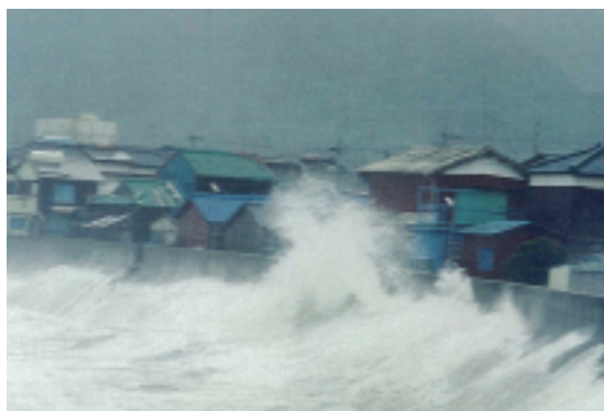
脇岬西南海岸 越波状況
