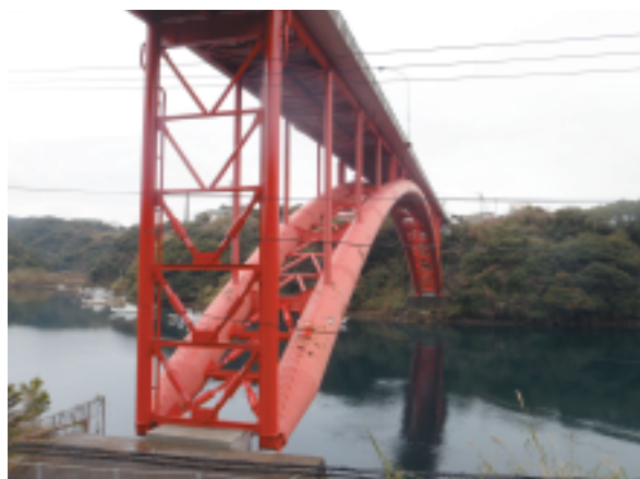
主要地方道 崎戸大島線(崎戸橋)落橋しない対策
