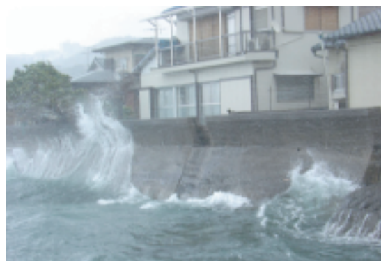
長崎港海岸 越波状況
