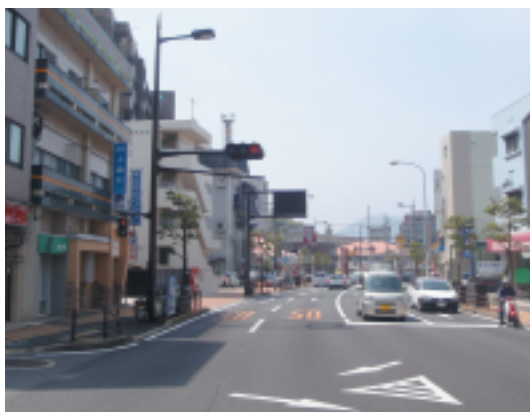
整備後 長与大橋町線(昭和町工区)
