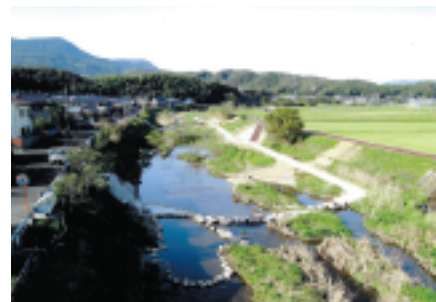
護岸、散策路の整備状況
