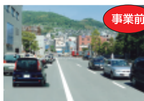
事業前 梁川橋踏切
