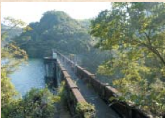
『小ヶ倉水源地堰堤』
