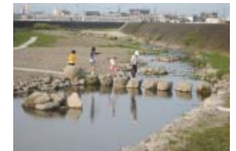
護岸、散策路の整備状況
