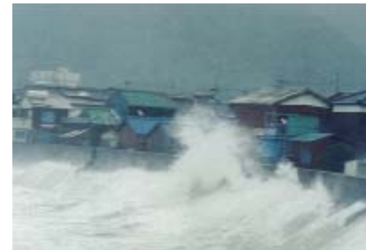
脇岬西南海岸 越波状況
