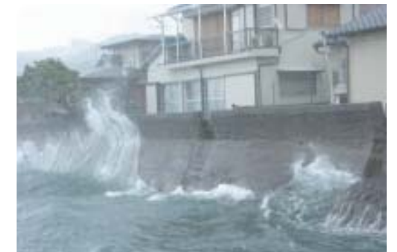
長崎港海岸 越波状況
