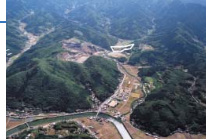
石木ダム建設予定地（川棚町）
