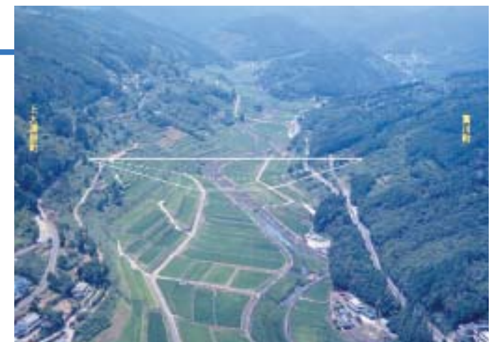
本明川ダム建設予定地（諫早市）
