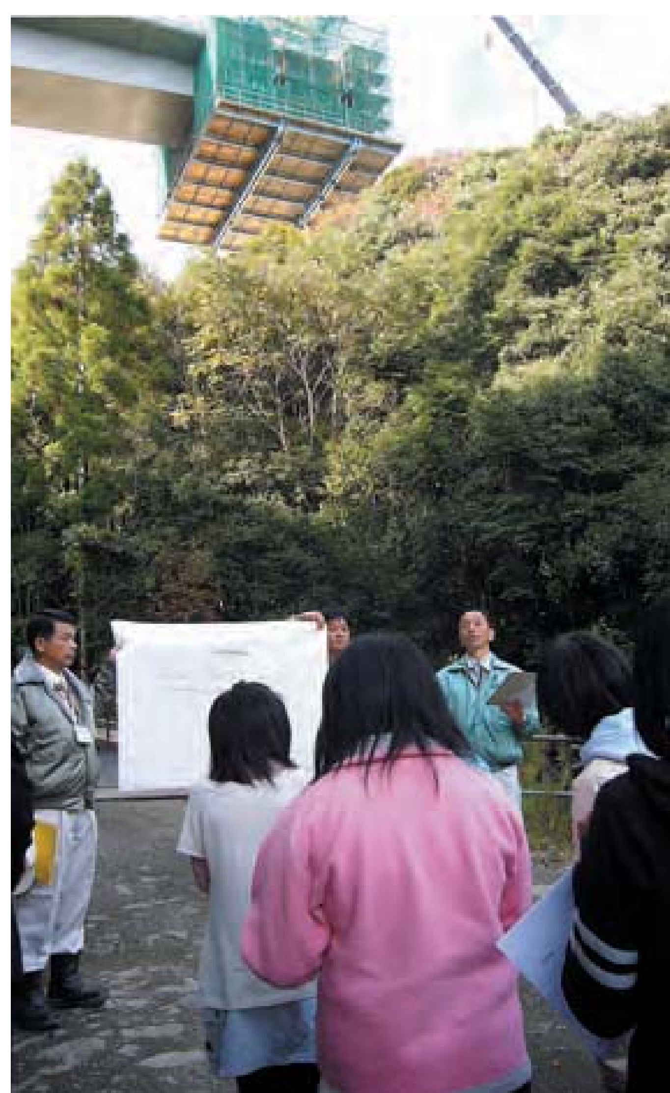
建設中の八木原大橋にて
