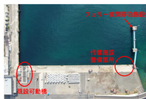
写真-4 代替施設整備箇所
