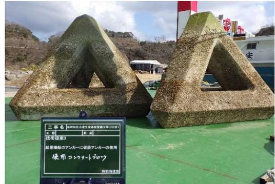
写真-6 仮設アンカーブロック
