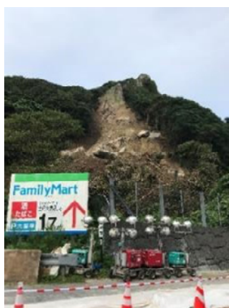
写真-4 監視視点
