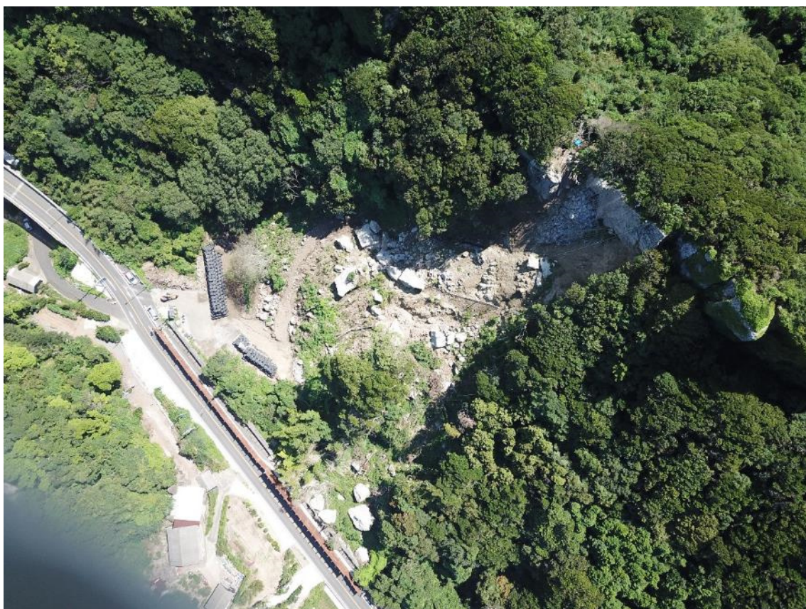
写真-12 斜面对策工事状況（令和3年9月現在）
