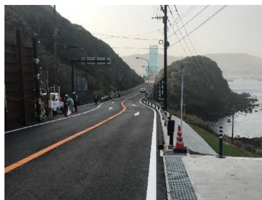
写真一〇 2車線確保（生月側より）
