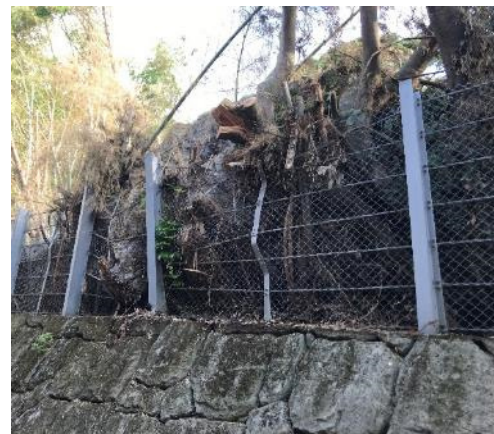
写真-3 既設落石防護柵による捕捉
