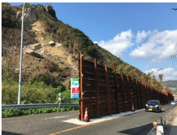
写真-5 仮設防護柵設置状況（平戸側より）
