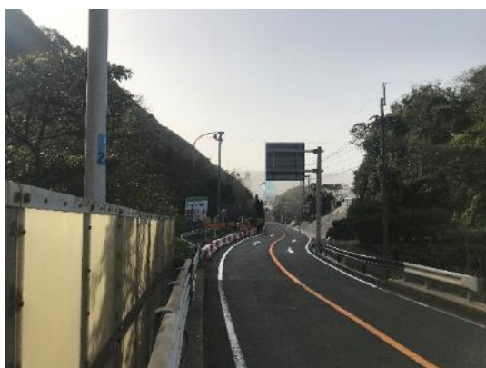
写真一〇九 2車線確保（平戸側より）
