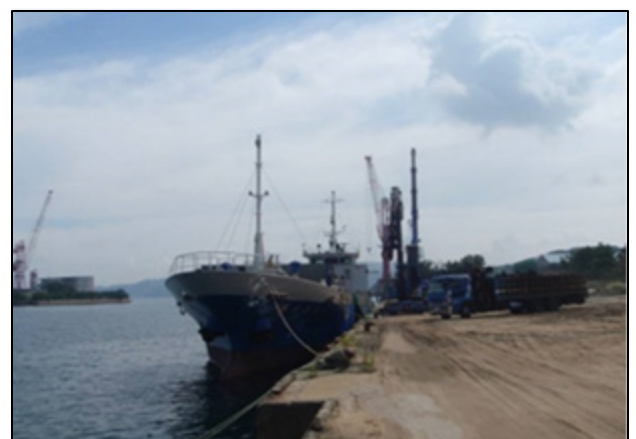
図-4 旧岸壁(-5.5m)の使用状況
