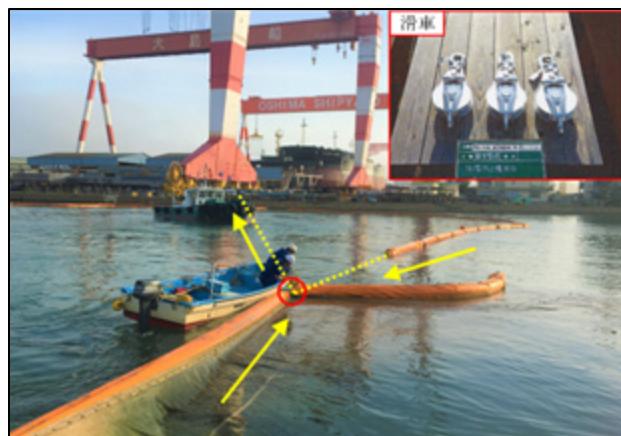
図-13 汚濁防止膜開閉作業の様子
