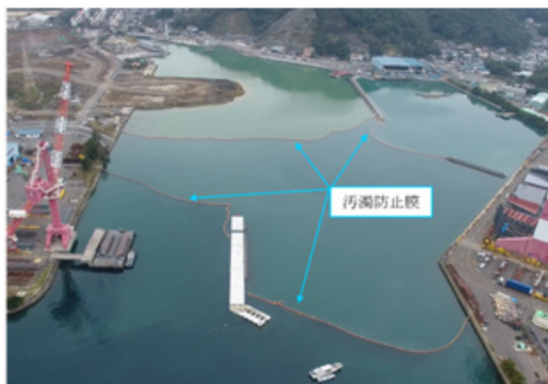
図-5 汚濁対策状況
