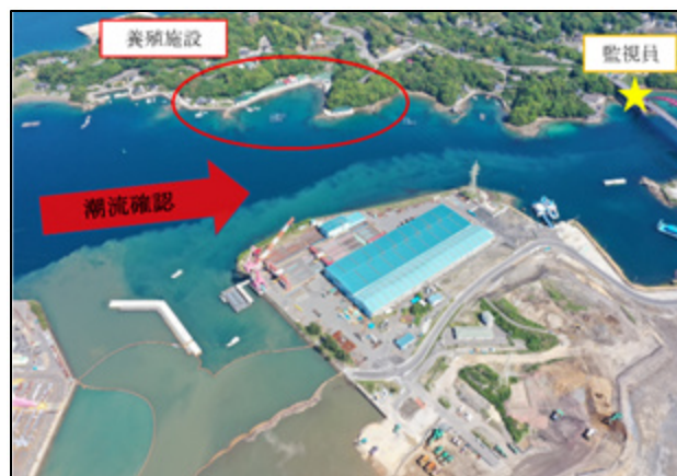
図-15 汚濁対策状況
