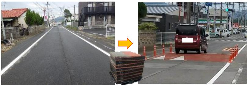
写真一1. ハンプ試験施工の前後
