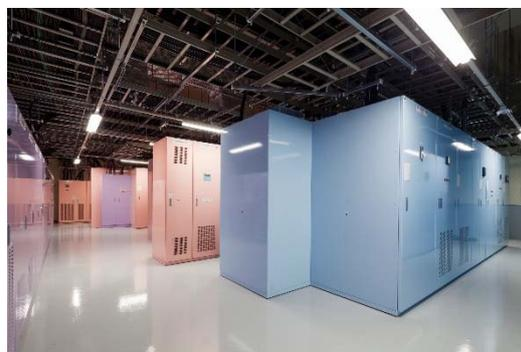
図6 高圧受変電設備色分け
