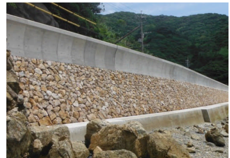
写真-1 改修後の江上護岸
