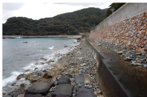
写真-4 干潮時の護岸前面の様子
