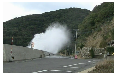
写真-2 江上護岸の飛沫発生状況
