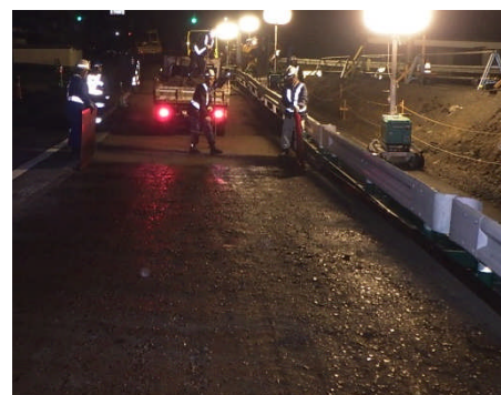
写真-2 大粒径As舗設状況
