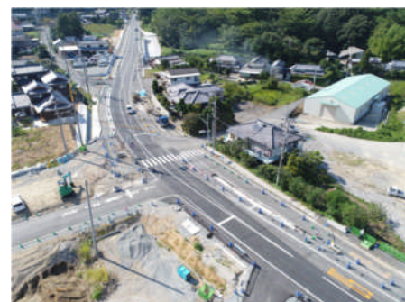
写真-3 子々川交差点 現況
