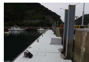
写真-7: FRP製簡易浮体
