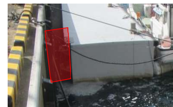
写真-12：異物混入防止ネットを設置
