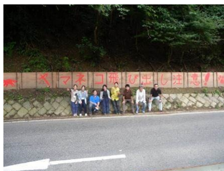
写真 - 6 仮設落石防護柵
