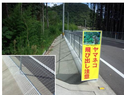
写真-5 OG付転落防止柵
