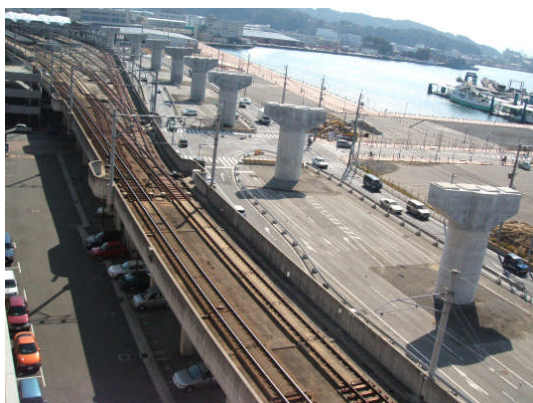
写真 5-1.西九州自動車道建設当時の 佐世保駅みなと口
