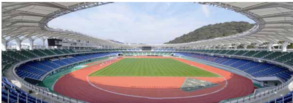
写真-1 県立総合運動公園陸上競技場フィールド
