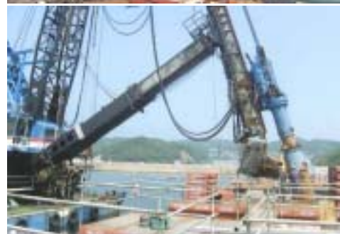
鋼管杭打設状況
