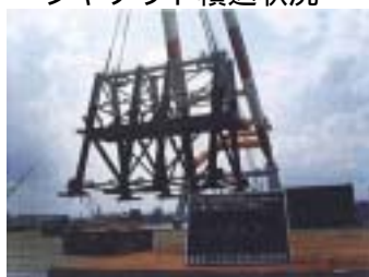
ジャケット積込状況
