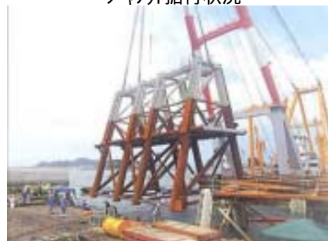
ジャケット据付状況
