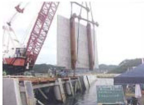
防波板取付状況
