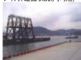
ジャケット運搬状況(門司港)
