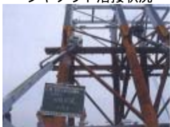
ジャケット溶接状況
