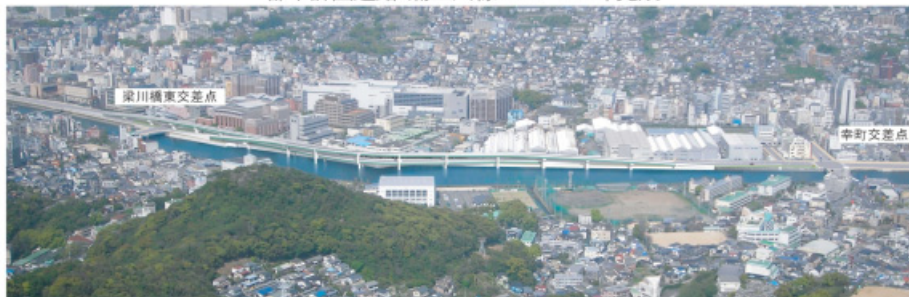
都市計画道路 浦上川線 2010年完成
