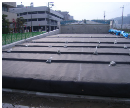
写真-7 遮水シート包み込み
