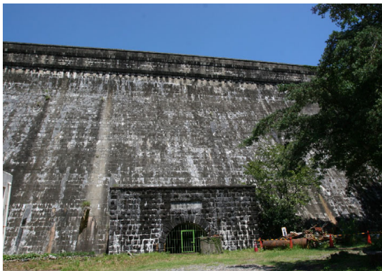
写真-1 堰堤下流面
