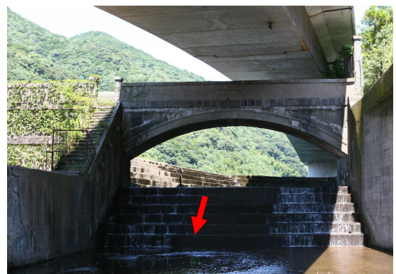
写真-2 放水路橋
