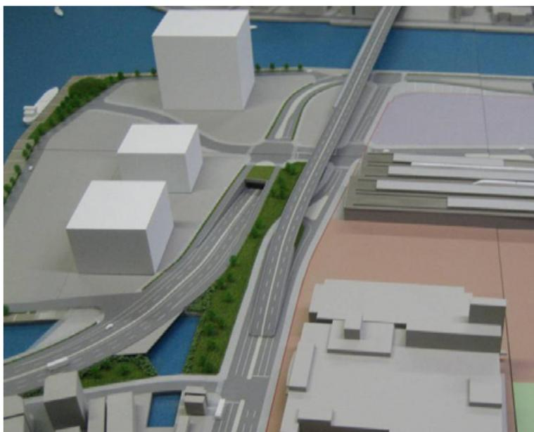
写真－5 アンダーパス方式の計画模型
