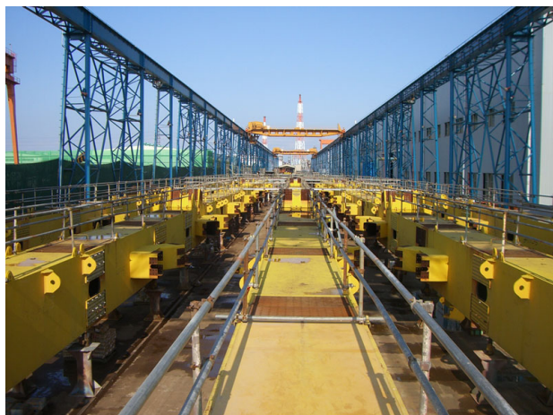
写真－２．確認組立状況
