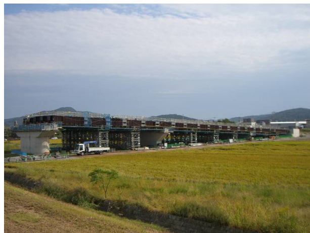
写真－５．桁架設完了
