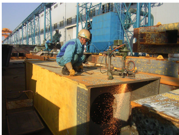
写真－３．転用部材改造状況
