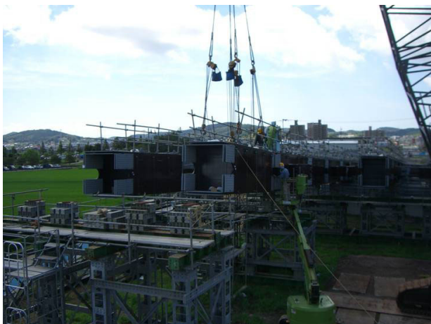
写真－４．桁架設状況
